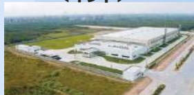
明電舎（杭州） 電気系統有限公司 ＜中国＞
